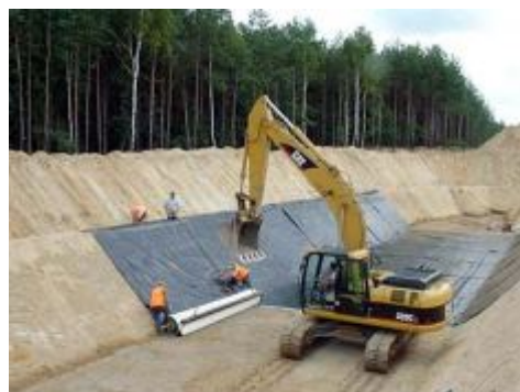
Układanie bentomaty pod nową kwaterą.
